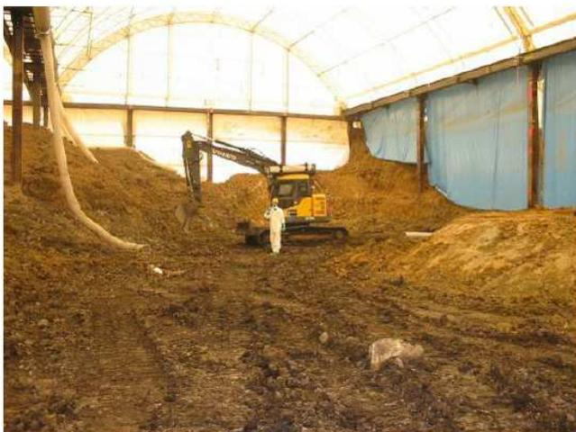
Pelle mécanique pour excavation des déchets
