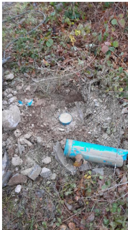
Découpage des tubages hors-sol et cimentation
