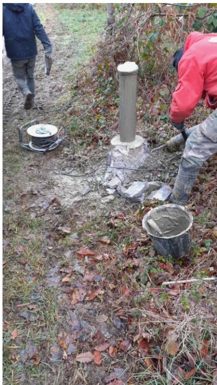
Démontage des têtes hors-sol et de leur massif béton
