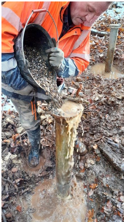
Contrôle de la profondeur de remblaiement et mise en place progressive du gravier
