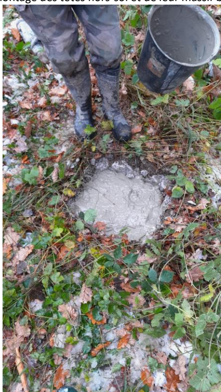
Bouchon de cimentation jusqu'au niveau du sol
